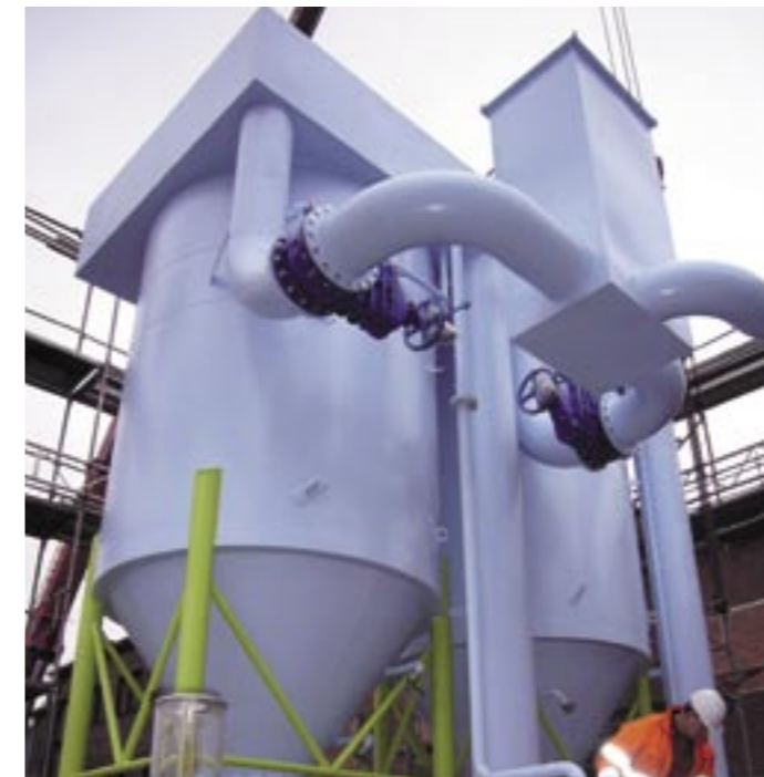
Galaxie-Tower für die Prozess- und Kreislaufwasserbehandlung.
