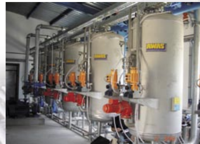
Сатураторы с дозаторами химикатов
