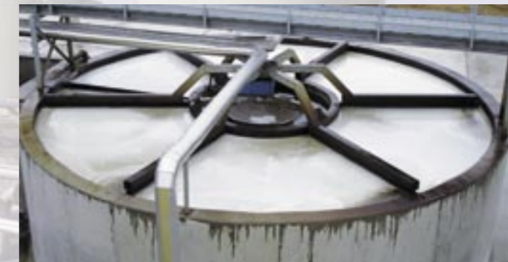
AWAS флотация с устройством сбора флотационной пены с поверхности
