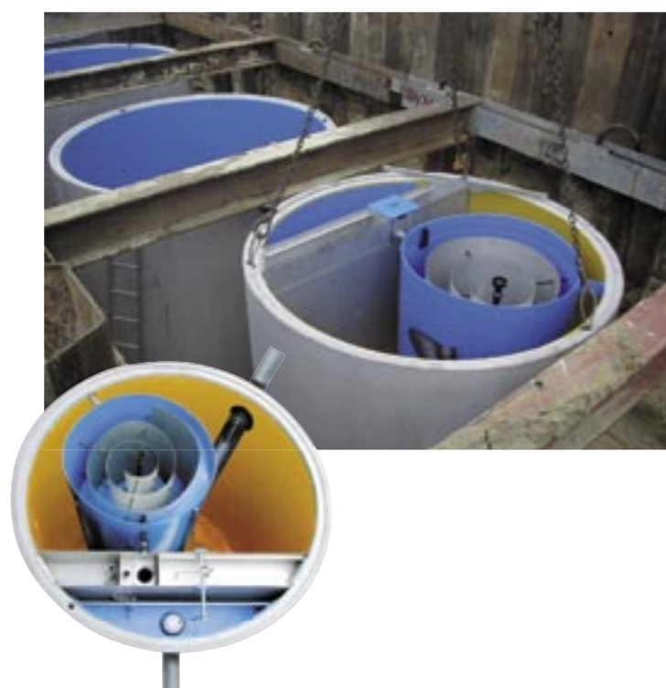
Galaxie 2002 для очистки стоков с территорий предприятий, на которых складировается и перегружается металлолом, не содержащий эмульсий
