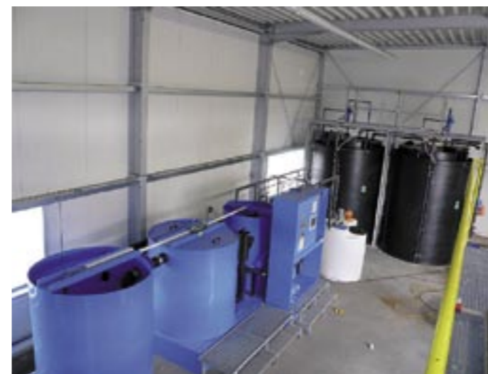
AWAS флотация и шламоосушающий камерный фильтр-пресс для очистки стоков с территорий предприятий, на которых складировается и перегружается металлолом, покрытый эмульсиями.
