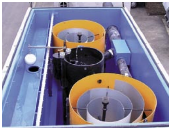
Galaxie 2002 для очистки стоков с территорий предприятий, на которых складировается и перегружается металлолом, не содержащий эмульсий
